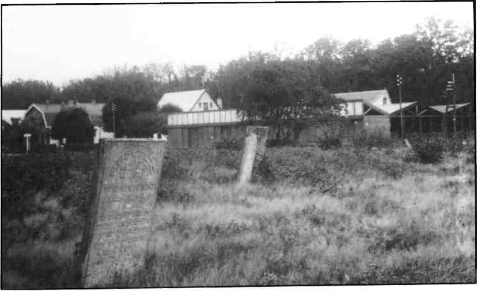
Het gebouw van de 'Coöperatieve Veilingvereniging Hilversum en Omstreken' gezien vanaf het voormalige Israëlitische Kerkhof aan de overkant van de Vaart, waar nu de Nieuwe Havenweg loopt. De foto werd ca. 1930 genomen. (coll. Goois Museum)
