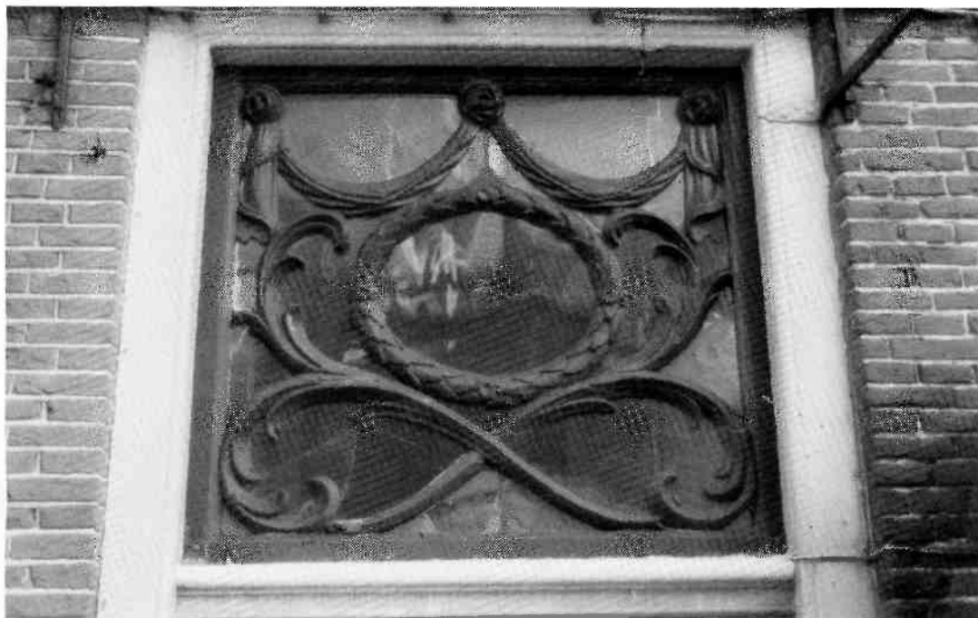
Boven de deur aan de noordzijde kon dit fraaie raam worden behouden.
