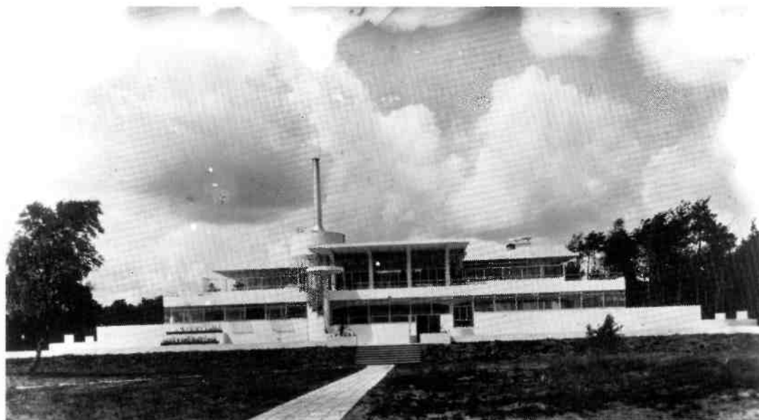
Aanzicht van het hoofgebouw van Zonnestraal aan de voorzijde, gezien vanaf de vroegere heide. De foto dateert van ca. 1930. Opvallend zijn de grote dakoverstekken, de glimmende metalen schoorsteen op het waterreservoir en de grote transparante glasvlakken.
