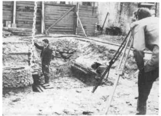
Het gebruik van een waterpasinstrument. Hier wordt de hoogteligging van een putrand gemeten.
