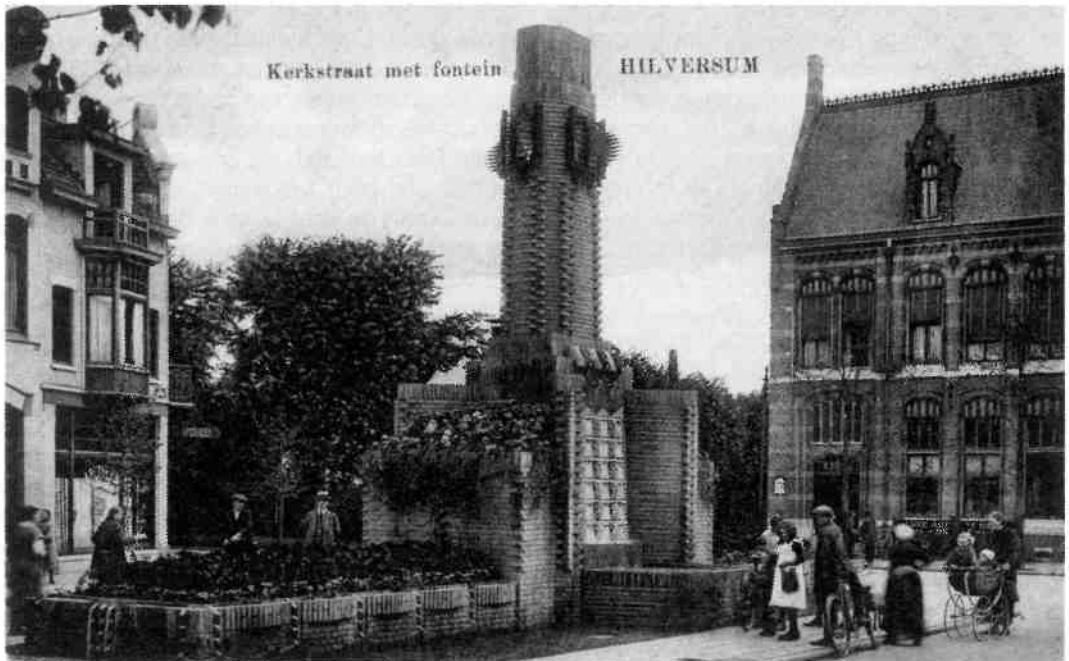
De Fontein van Dudok in de Kerkstraat werd gebouwd in 1916, een jaar na Dudoks komst naar Hilversum. Het werk behoorde samen met de werf aan het Langgewenst tot zijn eerste Hilversumse periode. Stijl is die van de Amsterdamse School. Het is een combinatie van bloembakken, baksteen en keramische tegels met een fontein en verlichting van bovenuit. De Monumentencommissie stelt voor het monument opnieuw te bouwen voor het plein van C&A, de plaats van het vroegere postkantoor. Afgebroken in de jaren '50. Foto ca. 1920 (Streekarchief Hilversum)
