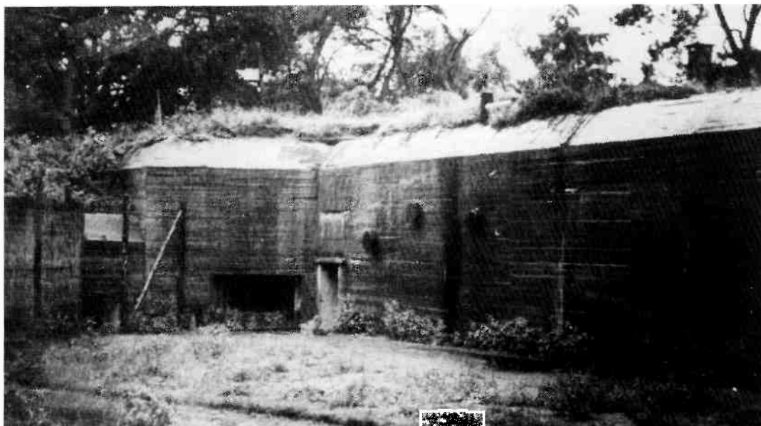
Het westelijke gedeelte van de grote commando bunker van generaal Blaskowitz aan de Rossinilaan. Deze foto dateert van vlak na de oorlog toen de bunker werd gebruikt voor het insluiten van 'foute' Nederlanders. Daarvoor werd de prikkeldraadomheining, links op de foto, aangelegd.
