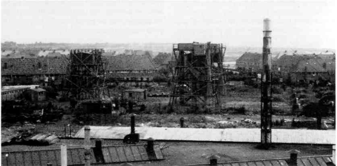
De twee Flaktorens met luchtafweergeschut op het NSF-terrein aan de kant van de Meteorstraat en het begin van de Orionlaan.
