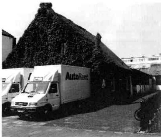
De boerderij Langstraat 48. Het dak van de vroegere stal is onlangs gesloopt en door een platte afdekking vervangen (foto E.J. Pelgrim).
