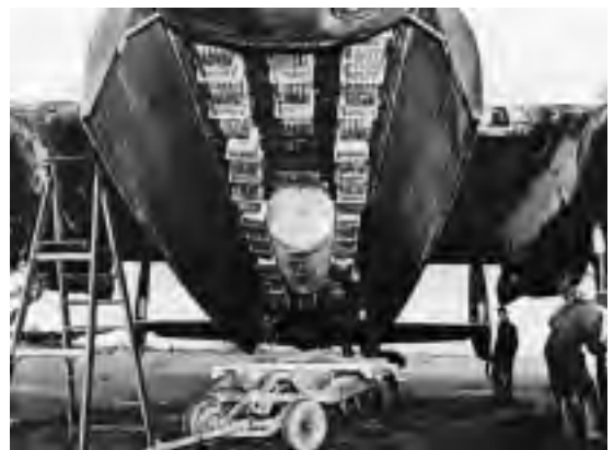
Een typische bommenlading voor een 'area-bombing' in 1943. In het midden de 1000 kilo zware, hoogexplosieve 'cookie'. De doosjes ernaast zijn de 'small bomb containers', die de brandbommetjes bevatten. (foto 207e squadron, mei 1943)
