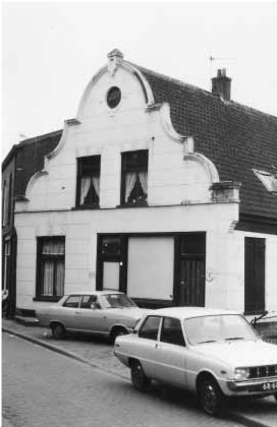
De 'Witte Boerderij' uit de Zon- en Maanstraat wordt herbouwd in de Laanstraat-buurt. Deze foto uit 1972 dateert van vóór de brand en de daarop volgende sloop. (foto Kees van Aggelen)
