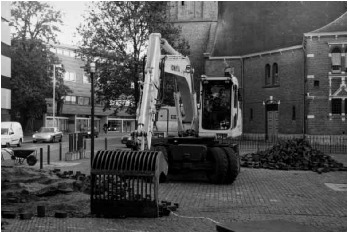
Het allereerste begin van het project: met een grote graafmachine wordt het 'klinkertapijt' opgerold. (foto: GM)
