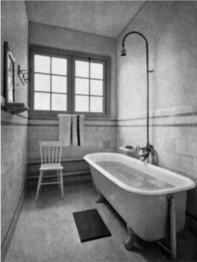
Badkamer met douche. Alle badkamers hebben geëmailleerde kuipen terwijl twee grote koperen kranen het mogelijk maken de temperatuur van het water zelf te regelen. (Uit: Prospectus)
