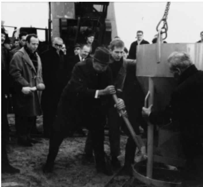
Het storten van het eerste beton voor het Lutherhof door burgemeester J.J.G. Boot op 14 december 1966. De woningen in dit hofje werden begin november 1967 opgeleverd. (coll. Streekarchief)
