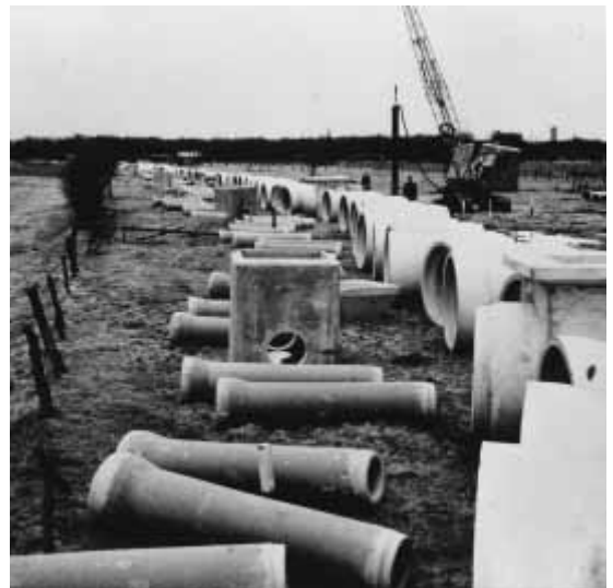
Bij de aanleg van de riolering in februari 1966 lagen her en der een groot aantal rioolpijpen. (coll. Stevens)
