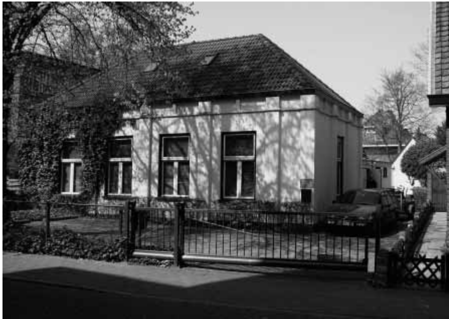
Dit voormalig schooltje Noordse Bosje wordt met sloop bedreigd. Foto: EJP.
