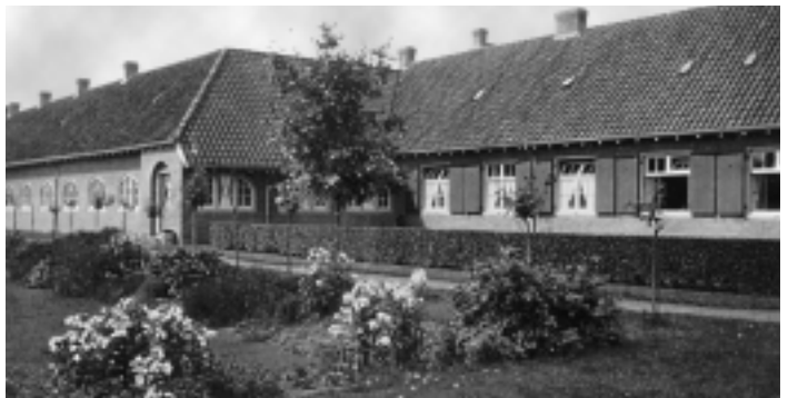
De Egelantier was het eerste zorgcentrum voor bejaarden in Hilversum. De fraaie binnentuin en de bouwstijl gaven het geheel een landelijke sfeer. (coll. MH)
