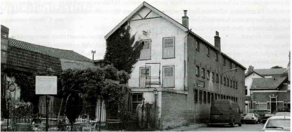
De “logerij” aan de Naarderstraat, oorspronkelijk de timmerfabriek van aannemersbedrijf Seppen. (foto: EJP)
