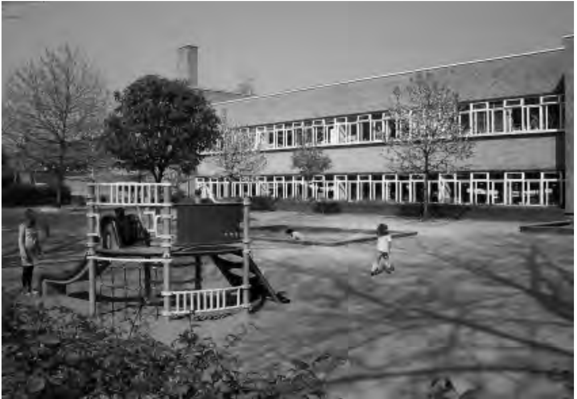
De in 1930 door Dudok gebouwde Lorentzschool heette oorspronkelijk school nr. 17, later de Valeriuschool (de benedenschool) en school nr. 11, later de Marnixschool (de bovenschool). (foto: Kees van Aggelen)
