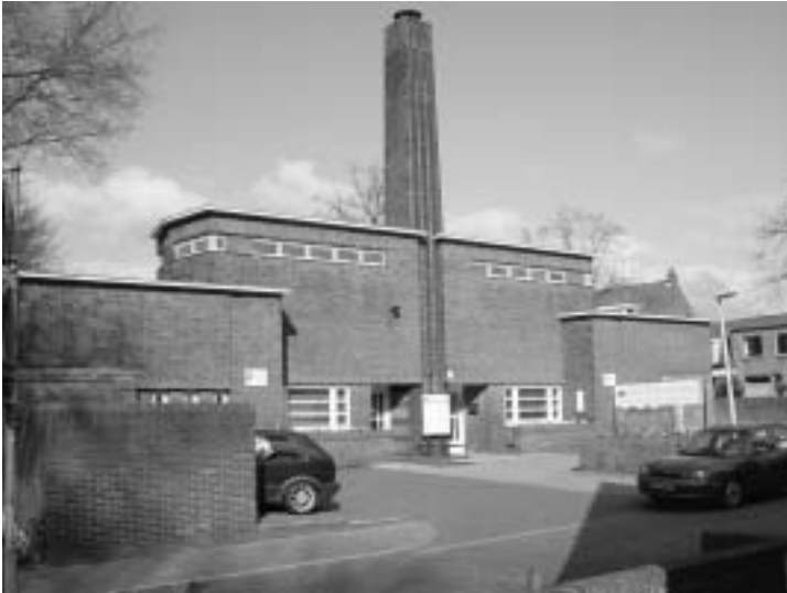
Het Volksbadhuis aan de Meidoornlaan. Architect W.M. Dudok. (foto: EJP)
