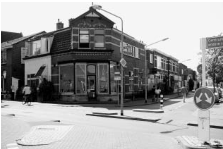
De hoek van de Neuweg en de Koningstraat, de plek waar ooit de gasfabriek van Hafkenscheid stond. De fabriek werd na 1885 afgebroken, waarna het terrein enige jaren braak bleef liggen. De huizen die er nu staan, werden kort voor 1900 gebouwd. (foto: EJP)
