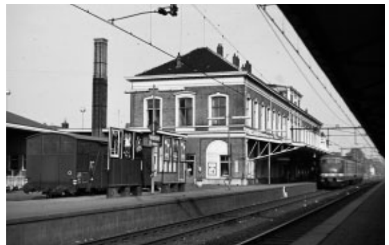
De achterkant van het oude station, gezien vanaf het middenperron. Links nog een stukje van de loods van Van Gend & Loos. Dit aan de PTT gelieerde goederenvervoersbedrijf had eigen zijsporen, waar de goederenwagon op staat. (foto: Nico Spilt, Bunnik)
