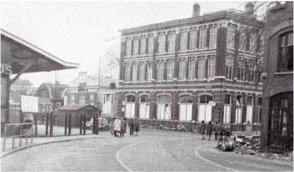
Het Wilhelminagebouw in de Spoorstraat, waar in de winter van 1914-'15 de spijskokerij was.
