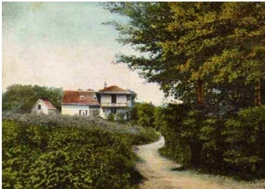
Het chalet op het Hoogt van 't Kruis, eigendom van projectontwikkelaar J.J.L. van Hengel, bood tijdelijk onderdak. Het jachthuis is in 1948 afgebroken.
