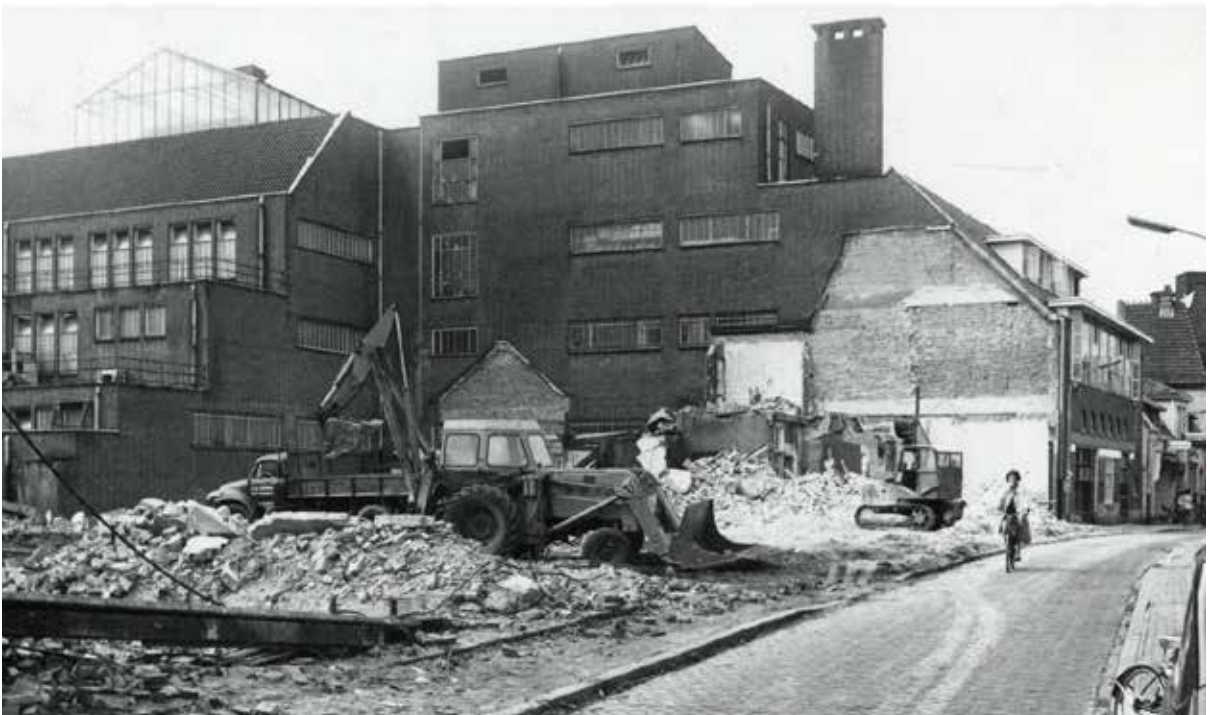
Op 14 augustus 1967 waren al veel panden aan de Zeedijk gestookt voor de nieuwbouw van V&D.
