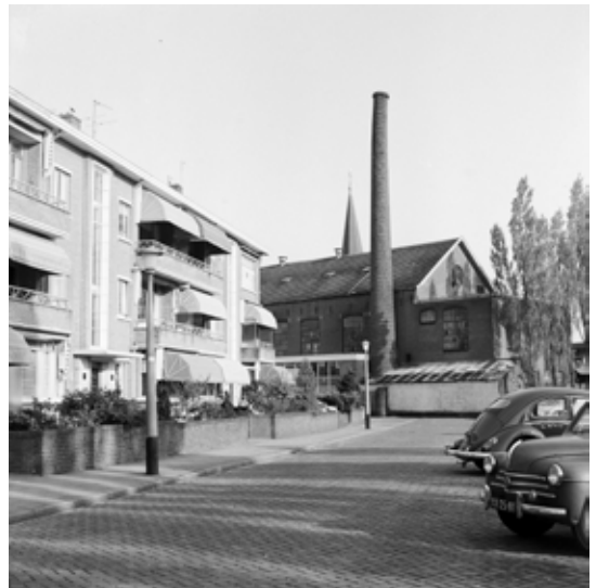
Burgemeester Andriessenstraat op 1 mei 1967. Rechts de Steendrukkerij De Jong & Co met een kromme schoorsteen, die op de nominatie stond om afgebroken te worden om plaats te maken voor de nieuw te bouwen hervormde kerk.
